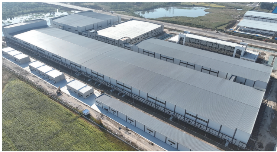
太蓝新能源安徽生产基地项目建设现场
