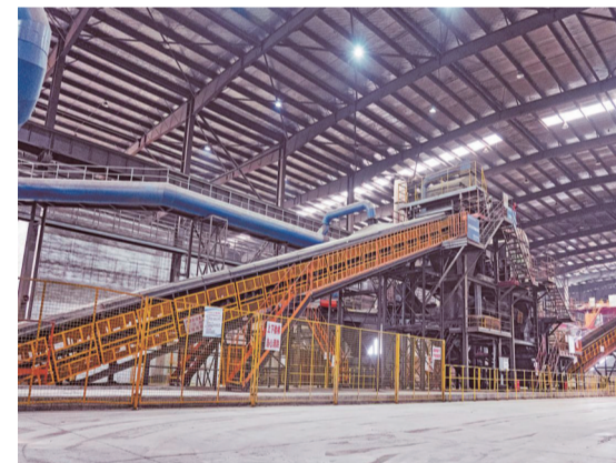
马钢诚兴金属资源有限公司华东地区最大产能破碎生产线
