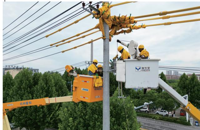
星报讯(记者 禹志强 通讯员 姚玉琳 黄元君 张海峰)7月23日上午10时许,室外气温高达36℃。在泗县10千伏中央公园130线1号杆处,国网泗县供电公司带电作业班技术人员正在进行加装真空开关及附件、接引线等工作,旨在更好地优化电网运行,确保全县人民清凉度夏。
