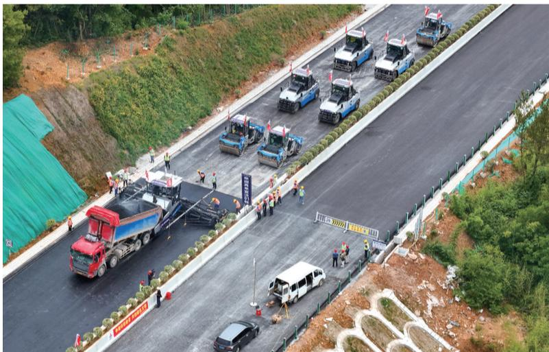
6月1日,在宣泾高速一期01标项目施工现场,安徽建工建设投资集团施工团队采用无人驾驶摊铺机、压路机,进行高速公路沥青面层的无人摊铺及碾压。此次施工是安徽高速公路项目首次实现“无人摊压机群施工”,对比传统有人施工,无人摊压技术可将施工效率提高约50%。
