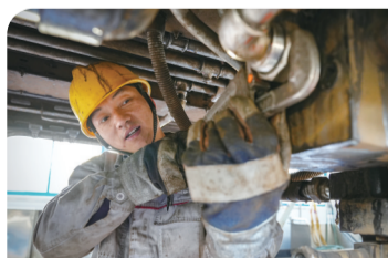
对旅客列车空气制动管系进行检查检修
