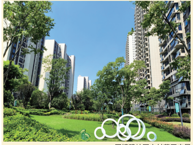
固镇碧桂园交付苑区实景
