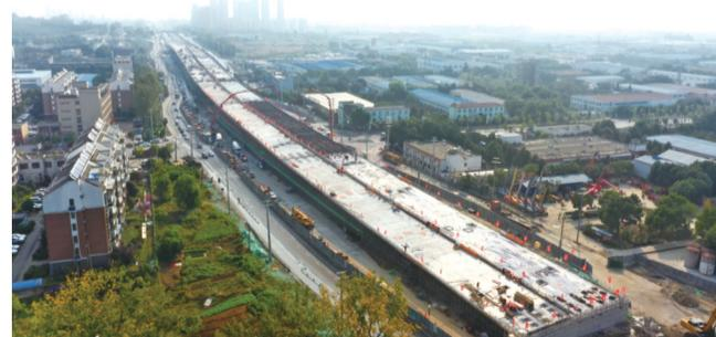
星报讯(周健 记者 王珊珊) 10月14日上午,随着合肥小蜀山西路上跨桥最后一联现浇箱梁顶板混凝土顺利浇筑完成,由安徽路桥公司承建的G312合六路(新桥大道-侯店路)工程二标段项目主线实现全线贯通,为工程主线放行通车奠定了重要基础。
