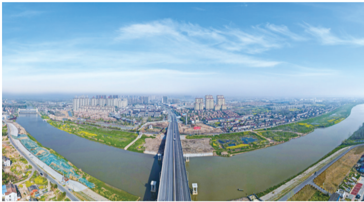
连接宁滁两地重要跨省通道汉河大桥建成通车
