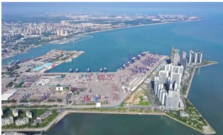
作为海南自贸港全岛封关运作第一批建设项目之一，海口秀英港将进行升级改造。
