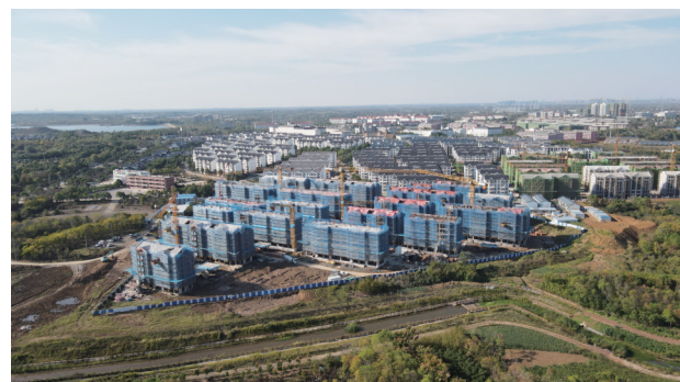
10月13日,新建肥西紫蓬山引江济淮安置点项目18栋主楼主体结构全面封顶,标志着新建紫蓬山引江济淮安置点项目工程正式转入砌体、二次结构及配套绿化施工阶段。该项目由中建六局安徽分公司承建。 马成龙 记者 赵汗青
