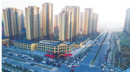
近期交付的新港南区安置点B区
