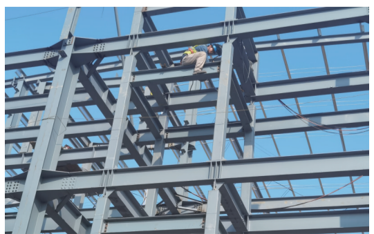
加快推进项目建设
