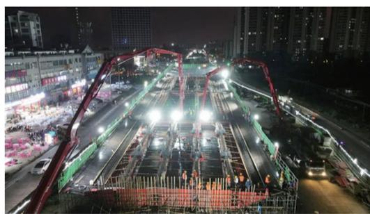
**星报讯(记者 祝亮)** 记者从合肥市重点局获悉,日前,由合肥市重点局建设管理的文忠路(郎溪路-少荃街)项目主线高架桥开始进行首联现浇梁顶板混凝土浇筑。
