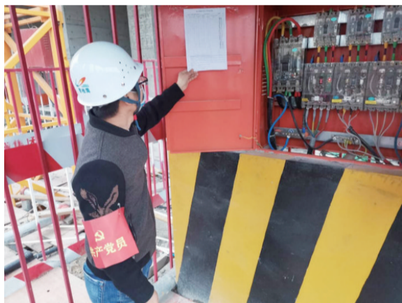
工地党员先锋岗
