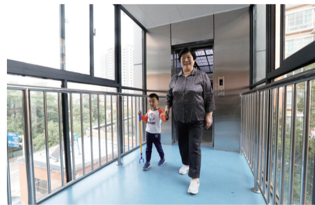
既有建筑加装电梯
