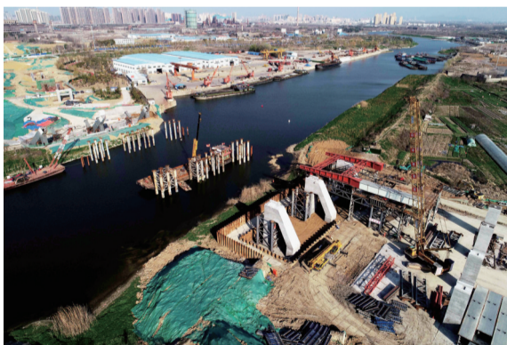
龙岗路跨南淝河大桥施工中
