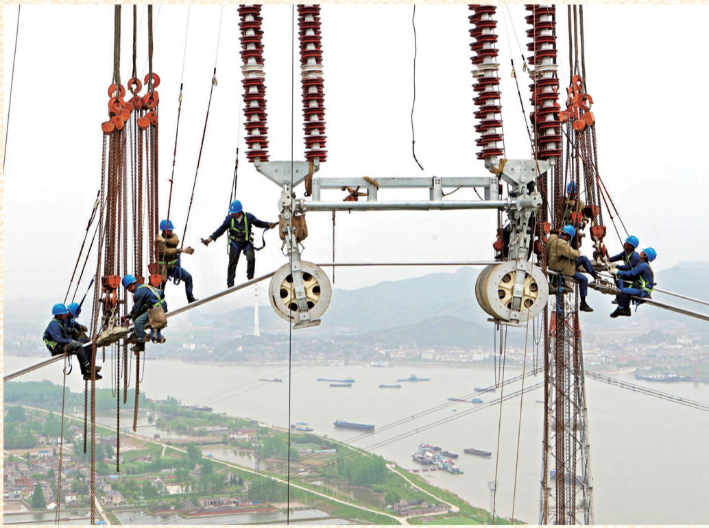
2018年,世界第一特高压完成长江大桥跨越,实现全线贯通。
