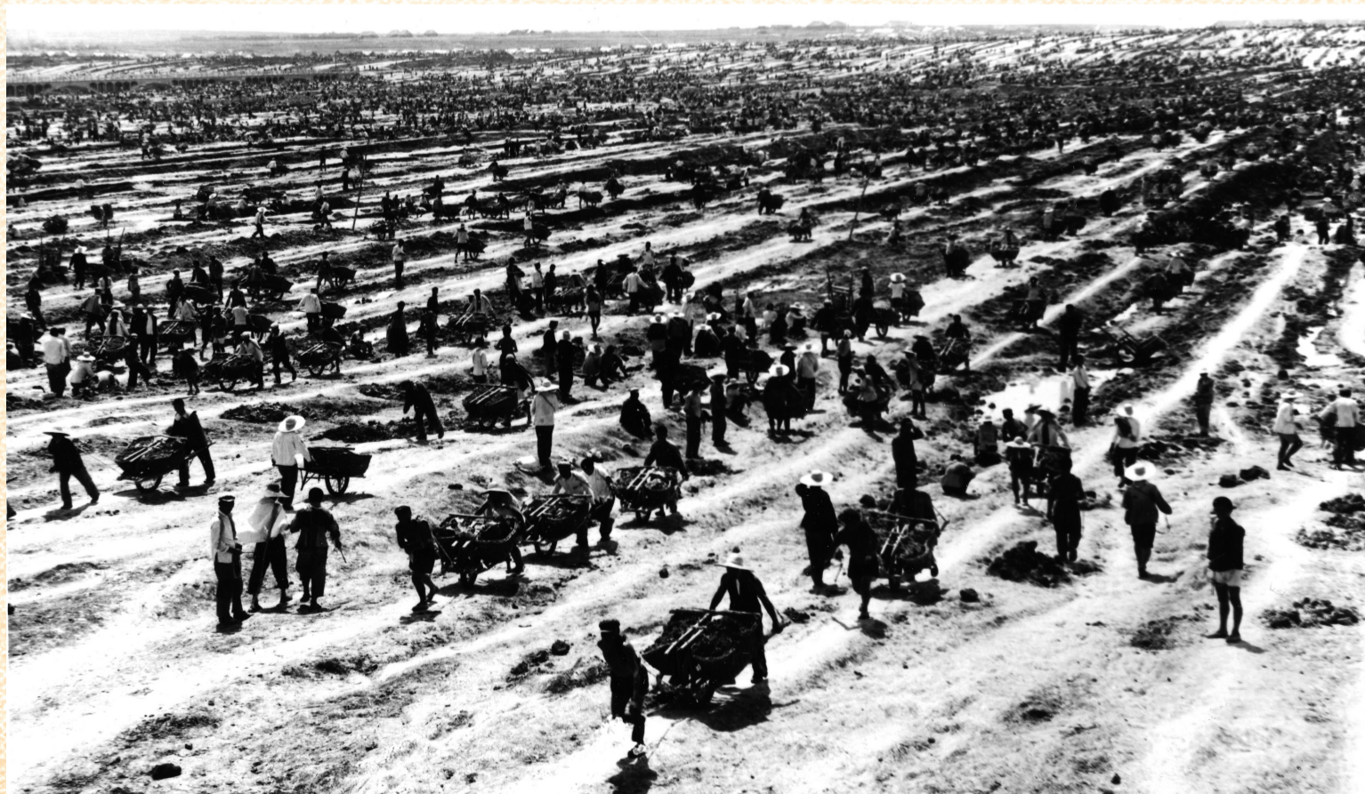
▼治淮施工现场
