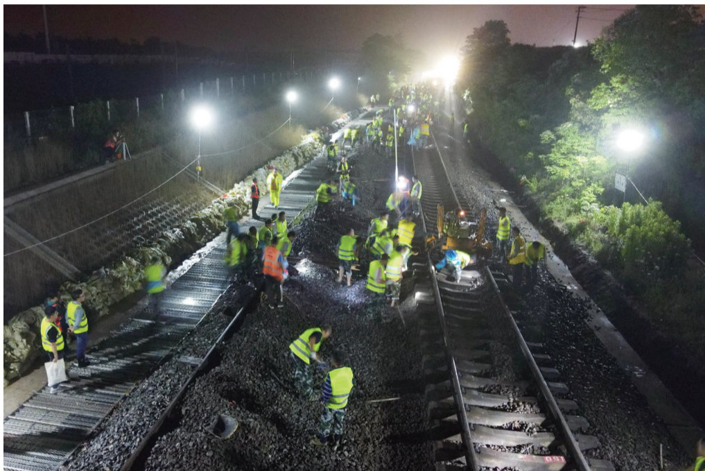
中铁十二局施工人员进行拨接施工(无人机照片)。 ■ 新华社记者 周牧/摄
