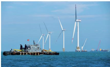
5月21日,一根直径6.7米的嵌岩单桩在福建省莆田南日岛西南侧海域成功植入海底。至此,由福能集团三川海上风电有限公司开发建设,中交一航局负责施工的29台单机容量7兆瓦风机(含6台嵌岩单桩基础型式、23台高桩承台基础型式)植桩全部完成,取得工程重要节点突破。 ■ 新华社记者 魏培全/摄
