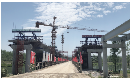
芜黄高速施工现场
