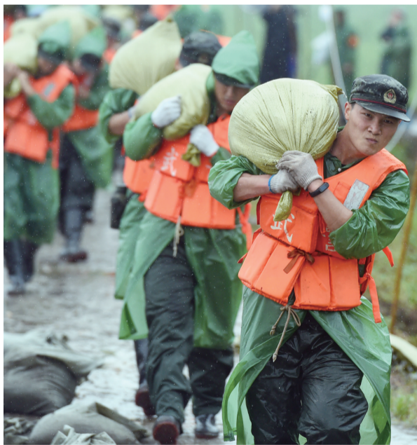
武警官兵在搬运沙袋加固子堤
