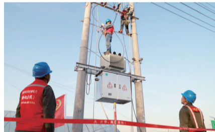
肥东供电公司梁园镇护城社区扶贫产业园架设变压器 陈海东/摄
