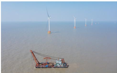
浙江舟山“岱山4#”海上风电场共设风力发电机组54台，总装机规模为216兆瓦，累计需敷设55根海缆，目前已完成39根敷设工作，预计将于今年10月底完成全部海缆敷设任务，建成后预计年发电量8.7亿千瓦时。届时，海上新能源将通过海底电缆源源不断为舟山鱼山岛的绿色石化基地提供发展动力。
