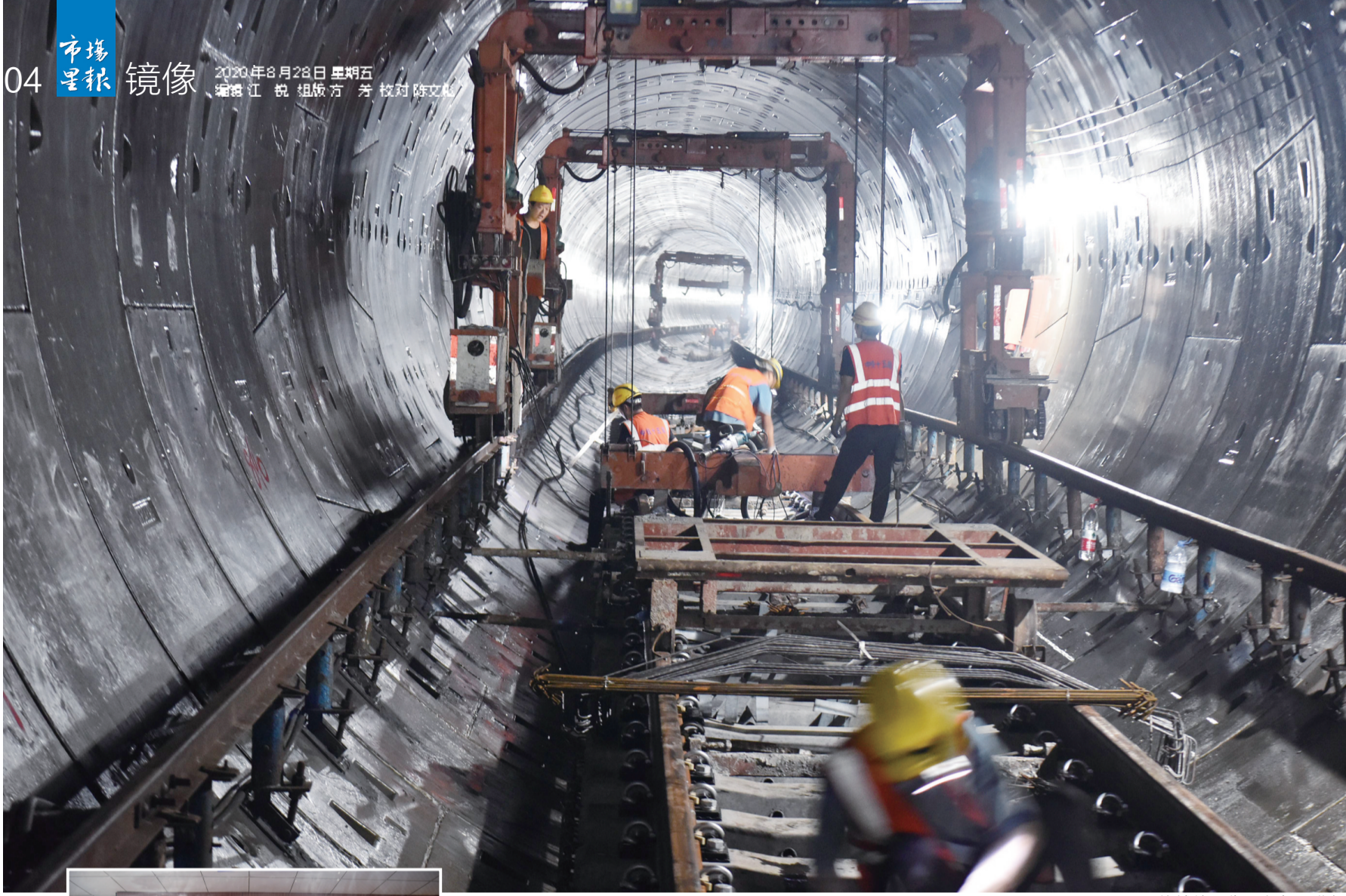
4号线铺轨工作正在紧张进行
