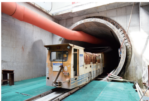
5号线休宁路站列车拉运土方
