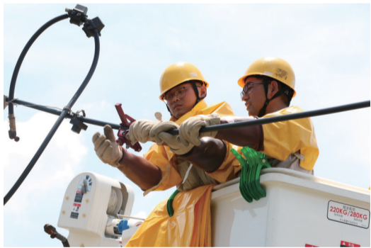
8月4日12时30分,合肥市庐州大道和太平湖路交叉路口,合肥供电公司工作人员采取不停电作业的方式将新电缆接入电网。 □ 李岩 记者 叶佳超 文/图
