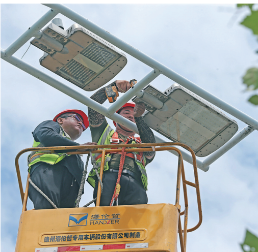
日在维修路灯。朝阳东路市政路灯所维修人员,头顶烈日
