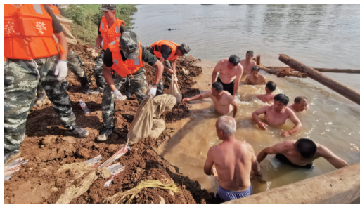
7月22日,党员突击队在全椒县新河东堤黄咀桥水下作业堵漏。 □沈果/摄
