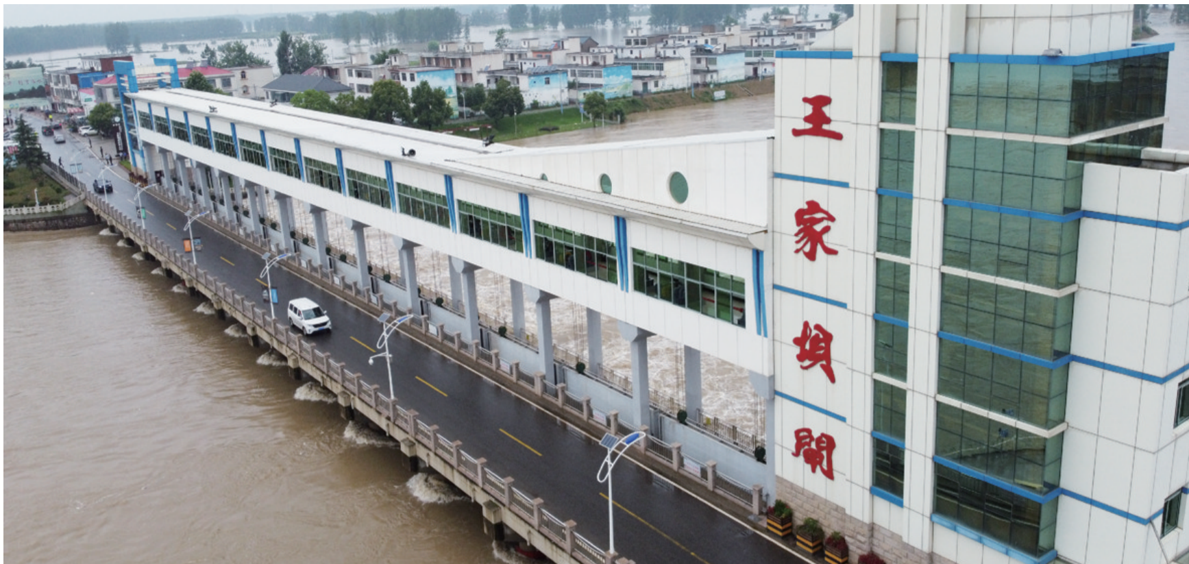
7月22日在安徽省阜南县拍摄的淮河王家坝闸(无人机照片)
