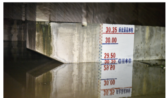
20日凌晨2点，王家坝水位已经达到29.45米，超警戒水位1.95米，超过保证水位0.15米。
