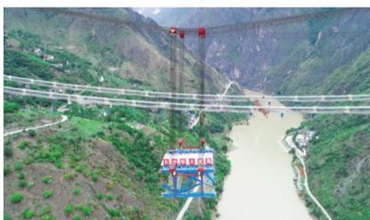
6月15日,缆索吊机在吊装钢桁梁。当日,随着缆索吊机将长24.4米、高12米、重640吨的钢桁梁平稳固定在吊索上,由中铁大桥局承建的丽(江)香(格里拉)铁路金沙江特大桥首片中跨钢桁梁架设成功。 □新华社发 姚思超/摄
