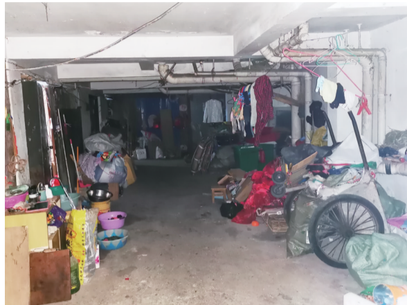
6栋地下室为保洁人员居住
