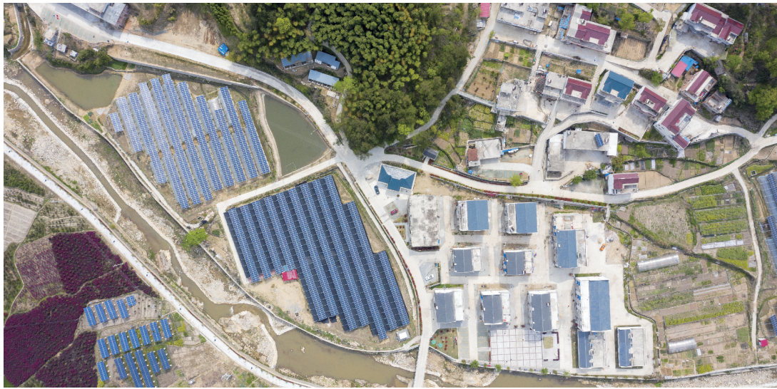
空中俯瞰金寨光伏扶贫项目
