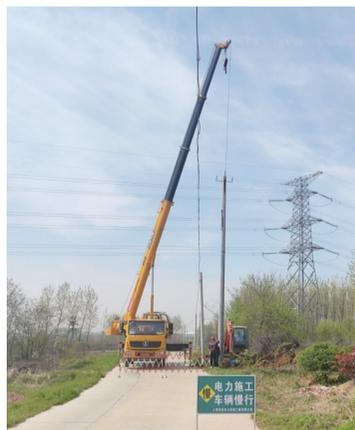
4月7日下午,长丰供电公司组织农网施工单位进行长丰县35千伏罗集变10千伏罗集05线刘老家、兴唐支线的改造施工。轰鸣的吊车横亘在长丰县罗集镇刘老家到兴唐村的乡村道路上,在进行该农网工程15米8#杆电杆组的立杆工作。进入3月份以来,该公司农网工程相继复工。截至目前,共有6个农网施工单位已经完成和正在开展11个农网工程的施工,预计迎峰度夏前能完成并投运31个,为长丰电网顺利“迎峰度夏”做好铺垫工作。
