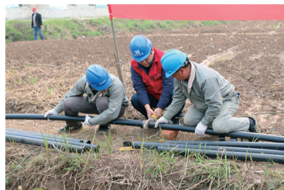
星报讯(查庆 胡云霞 文/图) 为帮助贫困户解决灌溉难题，确保扶贫小菜园早日发挥作用，近日，安庆市大龙山镇永安社区党支部积极联系安庆供水集团机关党支部和庆宁分公司党支部，共同开展“供水志愿砥砺前行 共筑乡村脱贫振兴”党建志愿活动。活动中，安庆供水集团机关党支部、庆宁分公司党支部无偿投入3万余元项目物资，并组织党员志愿者为永安社区20亩扶贫小菜园免费安装灌溉输水管道，援建扶贫小菜园灌溉系统，助力脱贫攻坚，同时还开展了“宜水专家”党建暨服务品牌宣
