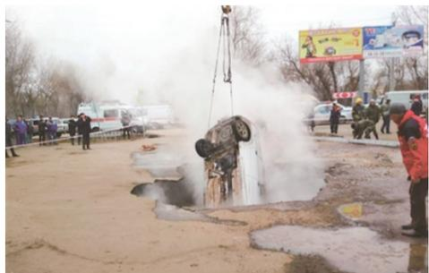
近日，在俄罗斯奔萨州一处停车场发生一起惨剧：一辆载有两名乘客的拉达汽车掉入塌陷的路面。导致路面塌陷的原因是，地下一根供暖水管破裂，水温高达75℃。两名被困乘客当场身亡。 □ 据《都市快报》
