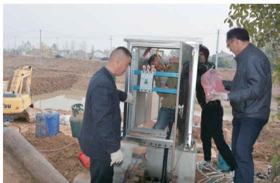
全椒县第二自来水厂的工人在安装应急取水设备，保障供水
