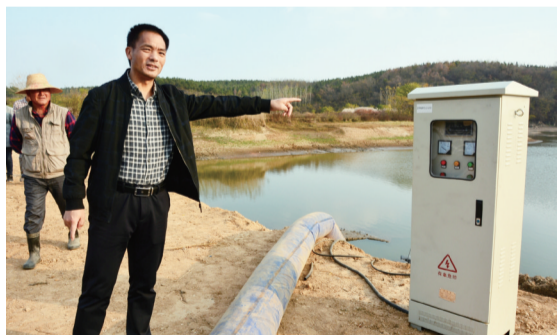
全椒县西王水厂在岱山湖下游筑坝架设临时机台提水，保障农村居民喝水安全
