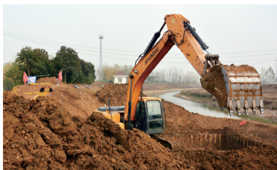
滁州市水利部门在全椒新龙河开挖应急取水口，将长江水送往滁州三水厂
