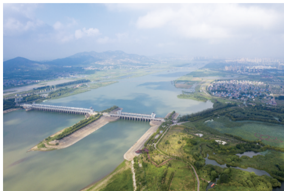
蚌埠闸水利枢纽为抵御淮河洪水发挥了重大作用
