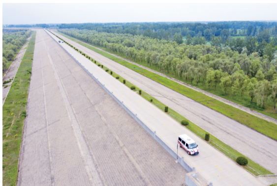
临淮岗主坝绵延 8.54 公里,十分壮观
