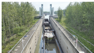
船只通过临淮岗船闸
