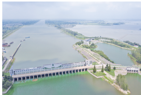
上桥枢纽是茨淮新河最末一级控制枢纽
