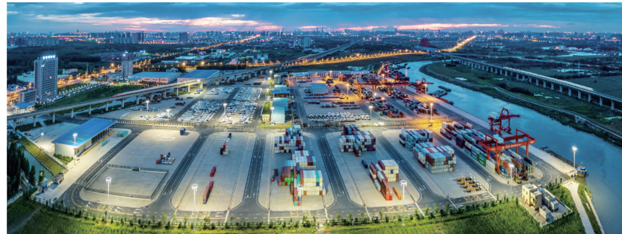
合肥港国际集装箱码头
