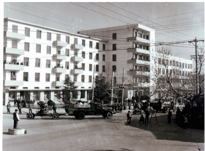
1978年前的合肥三孝口输电杆线
