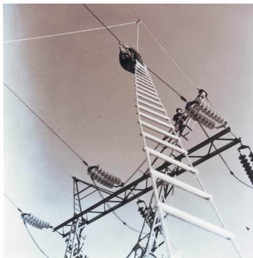
1962年，合肥西郊：电力工人带电作业
