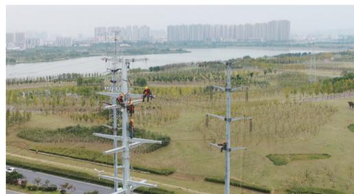
9月25日，电力工人在永和路110千伏游硕线23号塔上方高空，进行新建线路开断入方兴变施工作业，本工程是今年合肥电网重点建设项目之一。近年来区域用电量增长迅速，合肥供电公司科学进行需求预测，结合城市总体规划与新定位，加快城市电网建设。 □ 李岩
