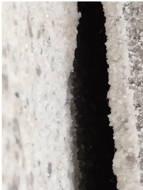
外墙瓷砖粘合不严，有的缝隙有指头大小
