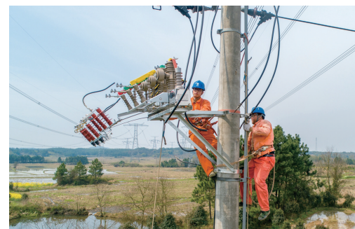
春回大地,万物复苏。3月24日,国网宣城供电公司组织百余人施工队伍对10千伏古楼154线路开展消缺及综合治理,提高了电网供电可靠性,服务百姓春耕生产用电。 □韦振 曹开发
