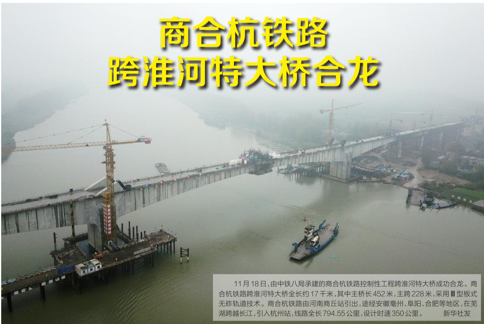
11月18日,由中铁八局承建的商合杭铁路控制性工程跨淮河特大桥成功合龙。商合杭铁路跨淮河特大桥全长约17千米,其中主桥长452米,主跨228米,采用Ⅲ型板式无砟轨道技术。商合杭铁路由河南商丘站引出,途经安徽亳州、阜阳、合肥等地区,在芜湖跨越长江,引入杭州站,线路全长794.55公里,设计时速350公里。 新华社发
