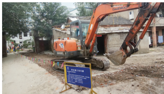
挖掘机正在破路铺设水管
