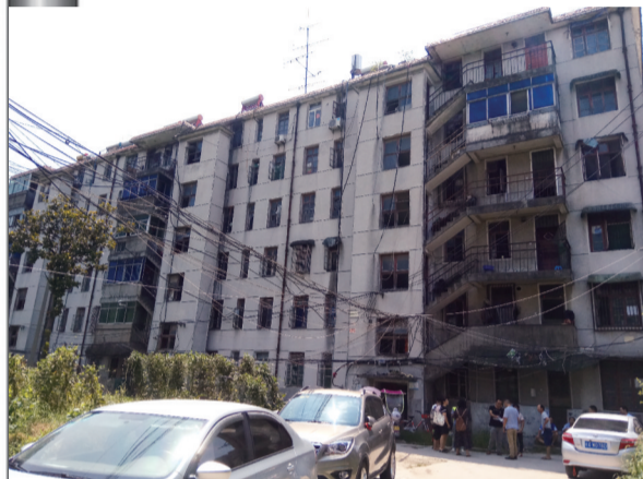
黄山大厦宿舍楼,三个单元,现有43户居民
