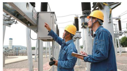
7月26日上午11时，长丰供电公司变电运维值班员杜宗文、张全巍来到110千伏兴湖路变进行高温大负荷下的巡视测温，排查主变、隔离开关等设备存在的隐患和异常，全力保障迎峰度夏期间居民的正常用电。
