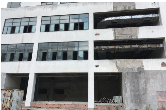
未完工的综合体外楼面
