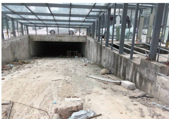
尚未完工的工程
