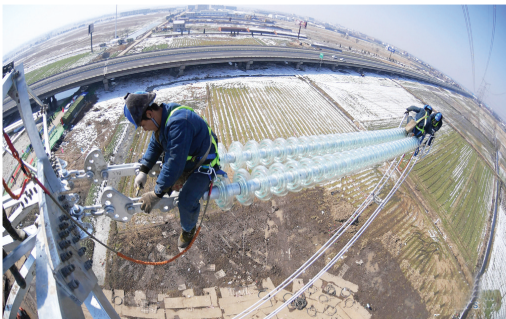
2月5日,在安徽省铜陵市枞阳县境内,国网安徽电力安徽送变电员工在50米高空的输电铁塔上安装附件。当日,“皖电东送”输电动脉、500千伏都山5392线工程经过施工人员为期八天的抢险施工,全面完成修复重建工作。至此,安徽此次因雪灾受损停运的500千伏输电线路全部修复,为安徽电网迎峰度冬及春节期间可靠供电提供了保障。 ■ 新华
