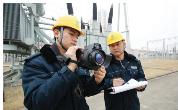
记者从国网合肥供电公司获悉,根据气象台发布寒潮蓝色预警,这几天,合肥地区或将出现大范围雨雪冰冻天气,合肥供电公司启动了应急响应,加强重点线路、变电站的设备巡视,全面掌握设备运行情况,做好有力应对措施。图为工作人员利用红外测温仪,对重点设备进行特巡。李岩文/图
