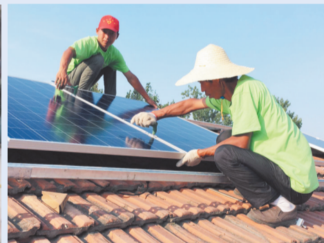
户用电站施工中
